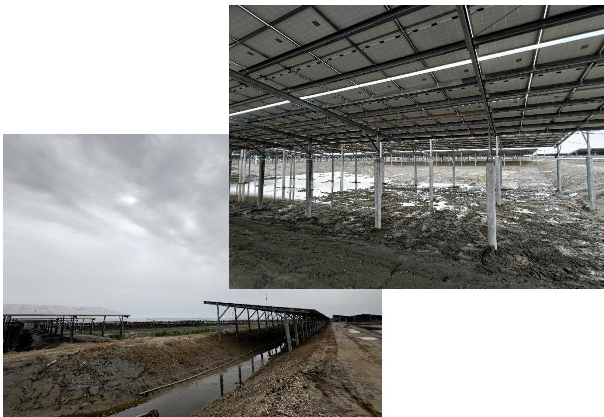
圖四、台南七股施工中的戶外型漁電共生案場
